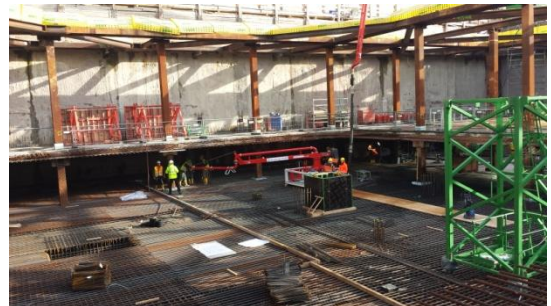
Oft wird nur eine kleinere Autobetonpumpe benötigt, als Rohrbrücke in die Baugrube, die Reichweite macht das Betonverteilermodul
